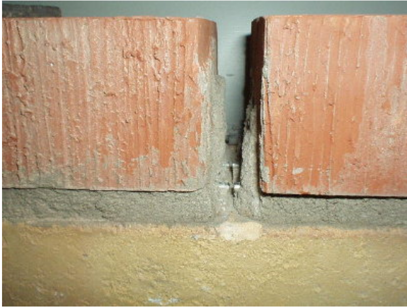
Bild C. Visar den urfrästa stötfogen, samt det avsågade bistålet.
