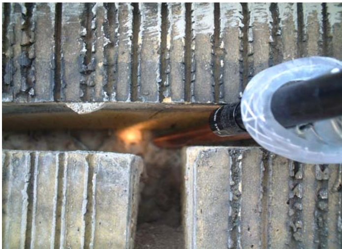
FÄST EN LAMPA TILL MUNSTYCKET VID FyllNING AV DJUPA FOGAR
